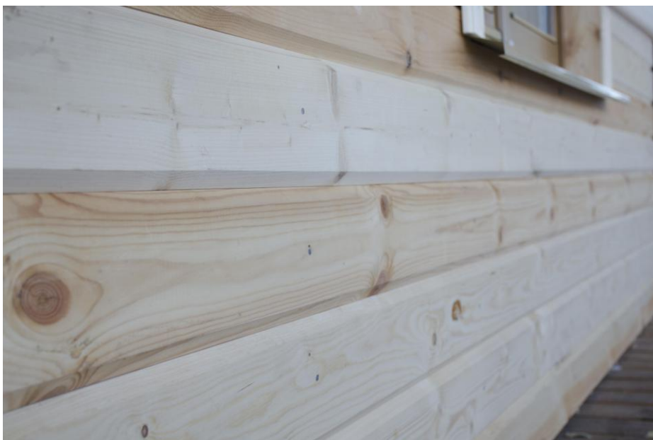
Наружная отделка каркаса.
